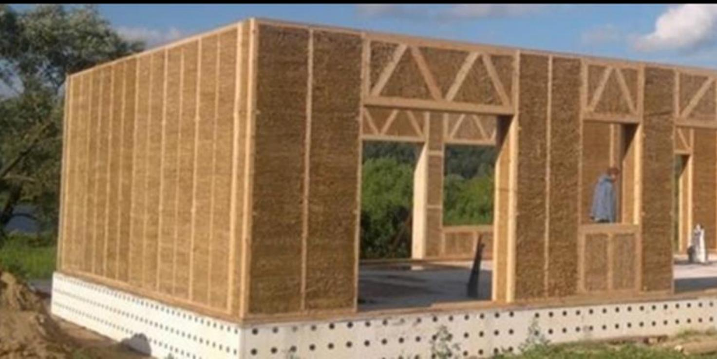
Tehnologija prefabriciranih panela od slame je jedinstvena jer pruža i konstrukcijski, nosivi element s dvostrukim okvirom i istovremeno glavnu izolaciju zgrade.
