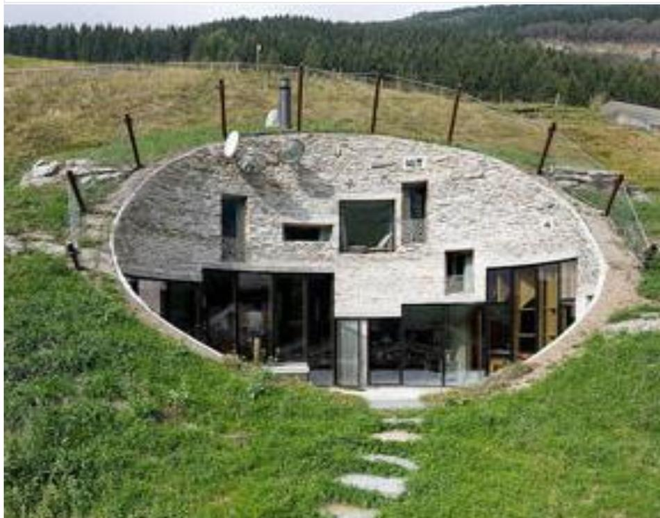
Primjer djelomično ukopane zemunice s otvorima za uvođenje sunčane svjetlosti i zraka orijentiranim prema južnoj strani. U potpunosti se poštuje postojeća konfiguracija tla, a intervencija u prostoru je minimalna.
