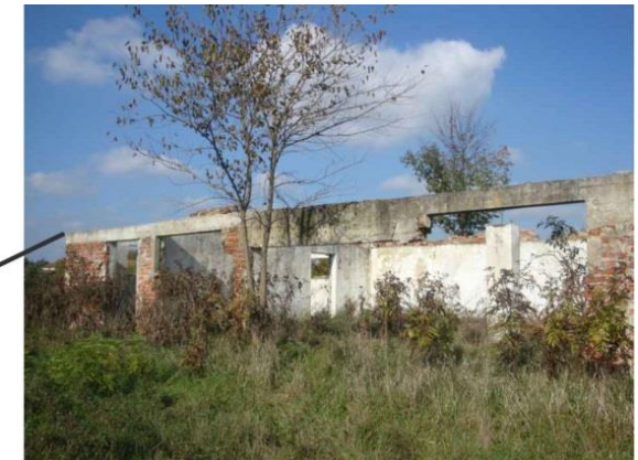
POSTOJEĆA POMOĆNA GRAĐEVINA
